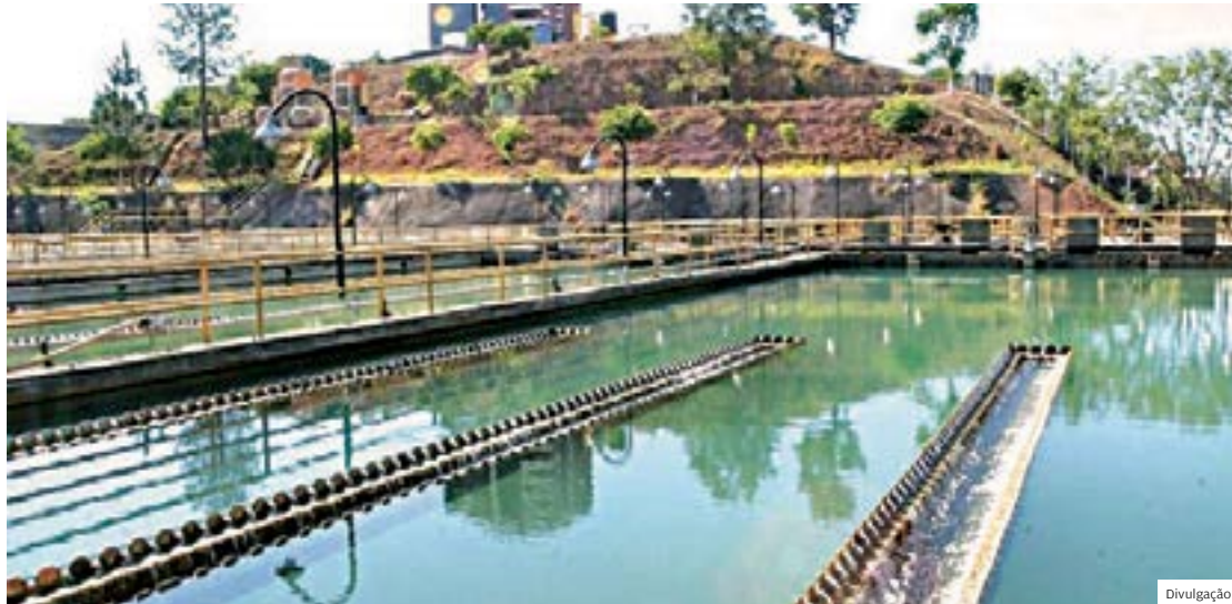
Tratamento. Estação de Tratamento de Água de módulo 1 foi implantada no ano de 1963 em Jacareí
