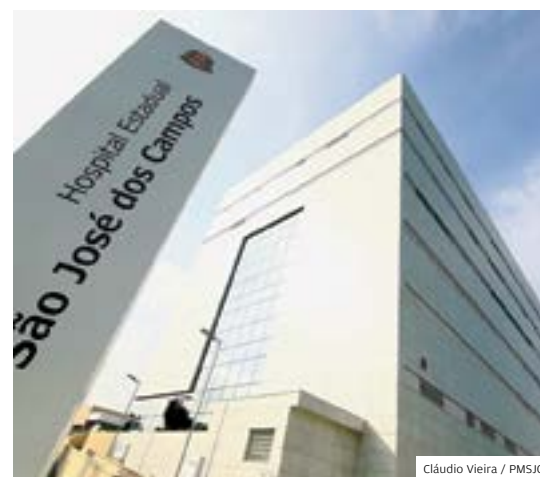
Saúde. Fachada do Hospital Regional, em S. José
