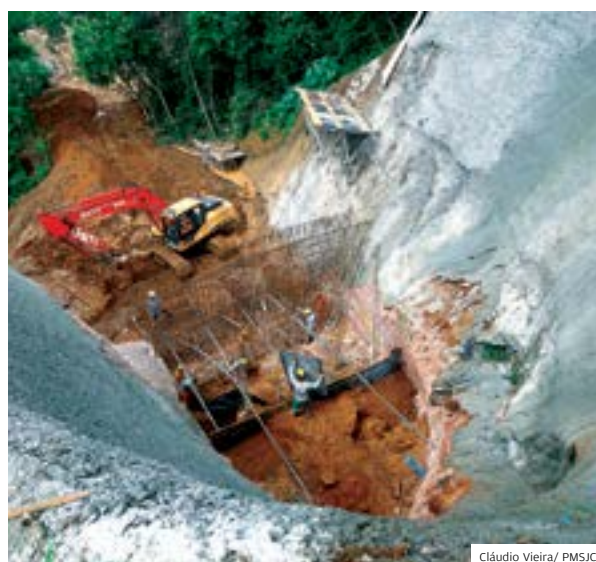
Zona sul. Obras de contenção no Jardim Del Rev
