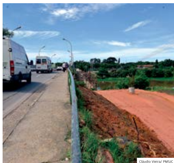
Acesso. Ponte Maria Peregrina: duplicação este ano
