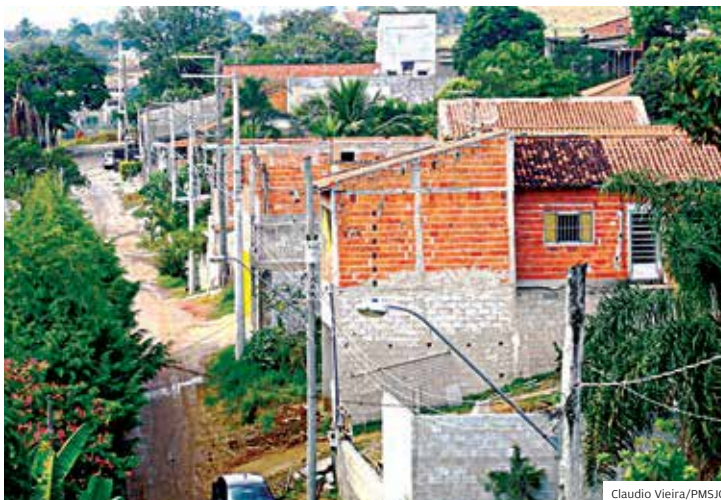
Regularização. Capão Grosso 1 deve ser beneficiado durante 2019
