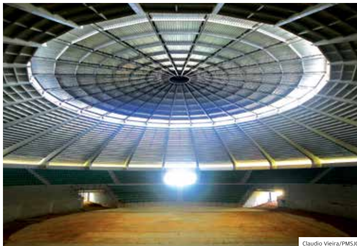
Teatrão. Complexo terá telhado demolido e nova estrutura erguida
