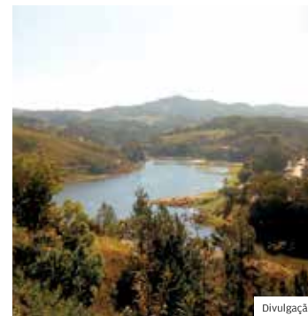
Risco. Represa em Redenção
