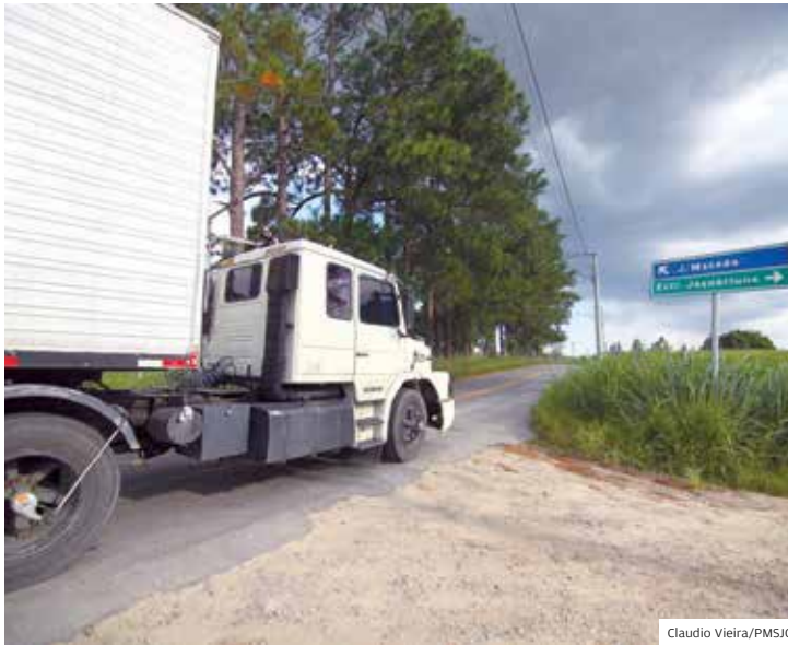
Via Jaguari. Serão quatro quilômetros de via, incluindo uma ponte
