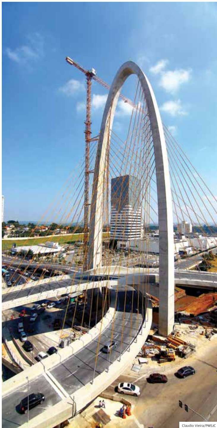
Arco. Ponte estaiada foi liberada ao tráfego nesta sexta em S.José
