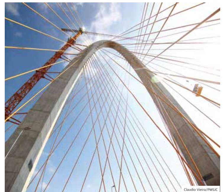
Trânsito. Arco foi construído com dois viadutos em formato de 'X'
