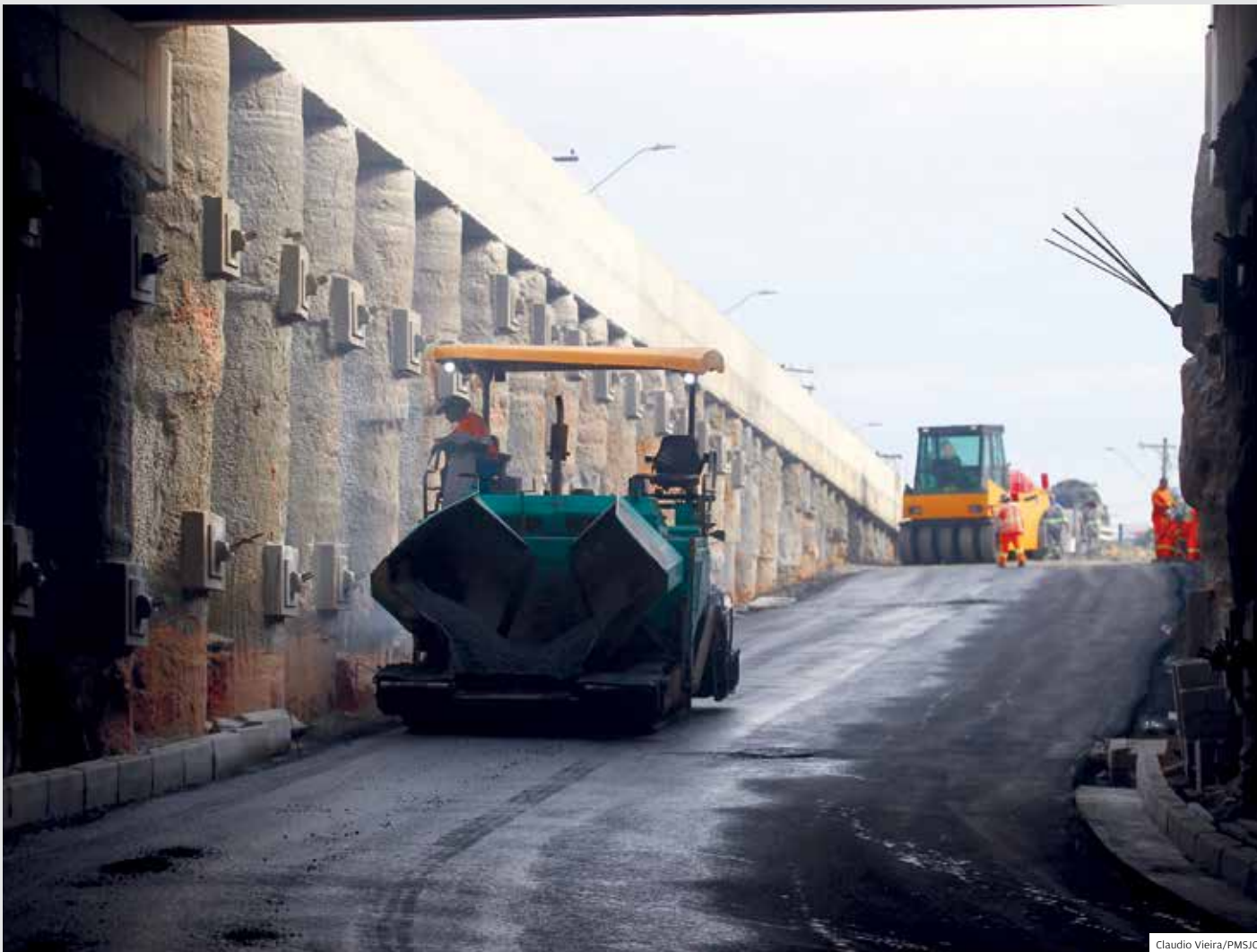
Cronograma. Pavimentação no túnel da Rotatória do Gás, em São José dos Campos. Obra está 12,7% mais cara e vai atrasar seis meses Claudio Vieira/PMSJC
