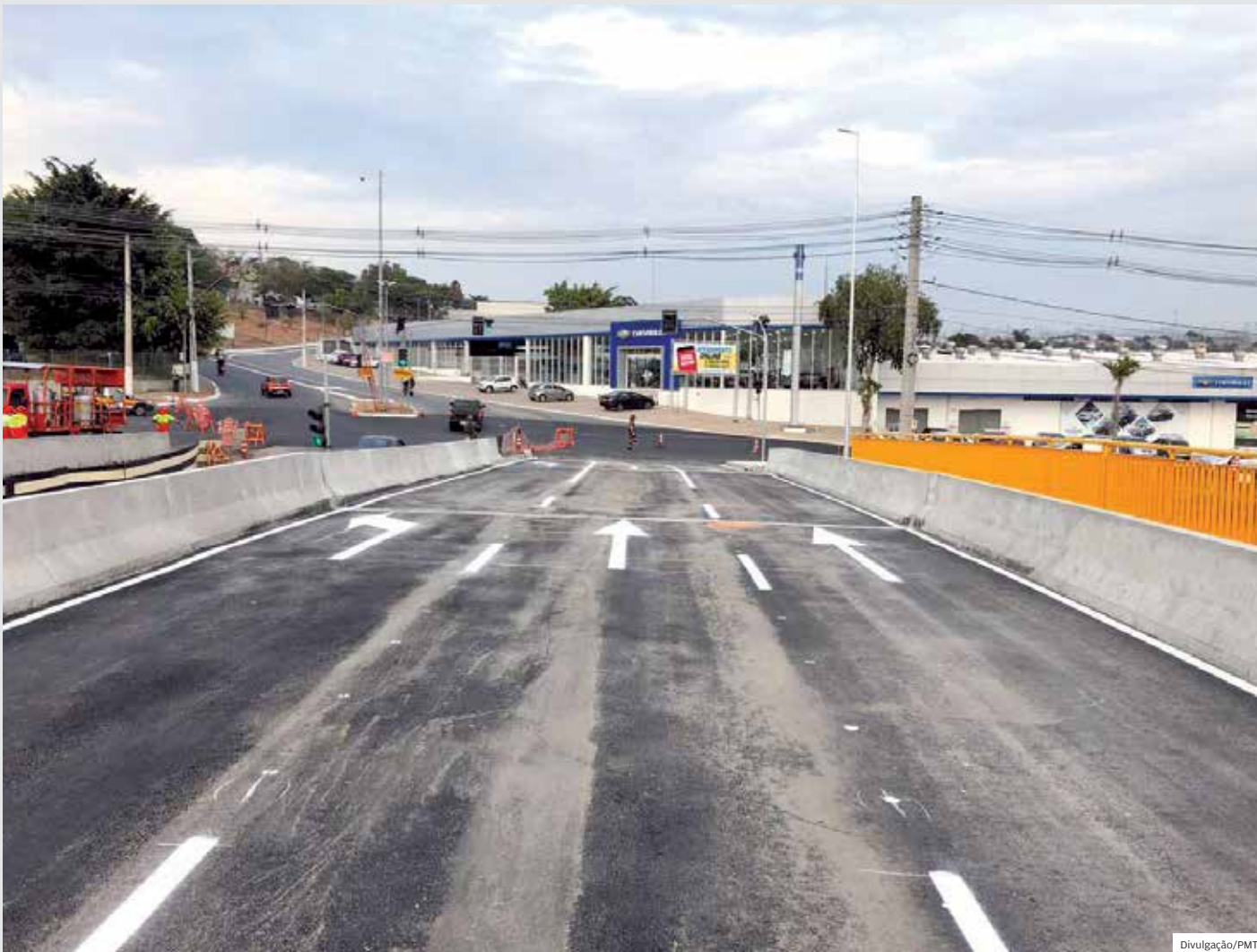
Obra. Cinco anos e três meses após o prometido, o viaduto duplicado do Cidade Jardim foi liberado para tráfego na quarta-feira (3) Divulgação/PMT
