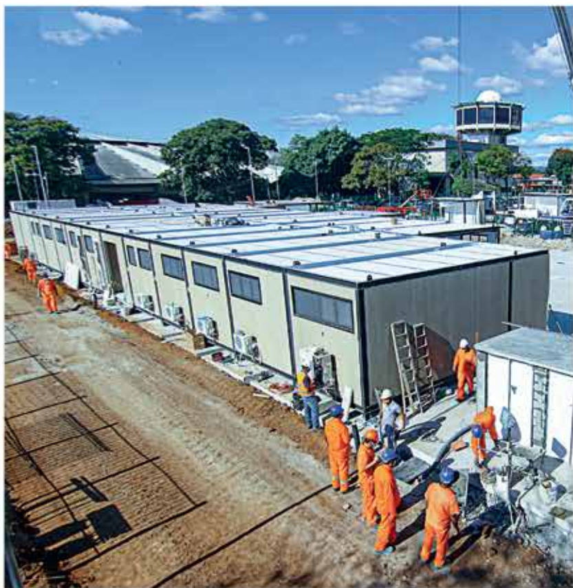
Construção do Hospital de Retaguarda
