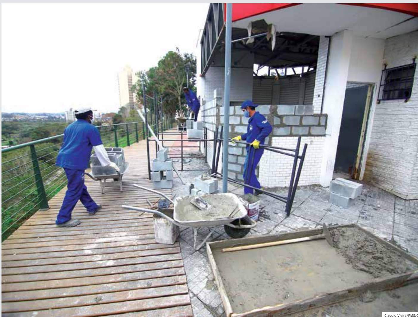
Obra. Após denúncia de abandono feita pela oposição a MP e TCE, governo Felício iniciou a reforma de quiosques da orla do Banhado
