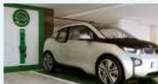
Ponto de carregamento
