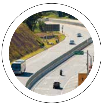
Obras. Trecho do planalto foi o primeiro duplicado
