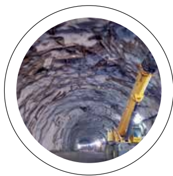
Ações. Construção de túneis, viadutos e pontes
