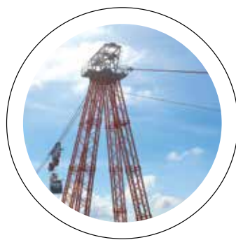
Obra. Utilização de teleférico de carga para transporte
