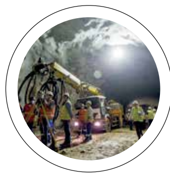
Tatuzão. Máquina para escavar a montanha e fazer túnel
