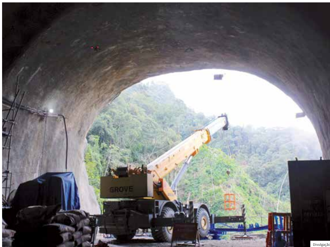
Engenharia. Construção dos túneis consome 70% do tempo da obra
