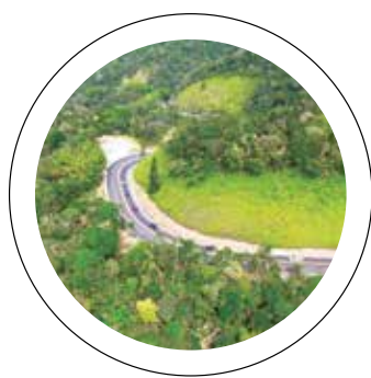
Andamento. Secretário destaca obras da serra da Tamoios
