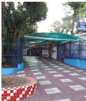
Escola. Ana Berling em obras
