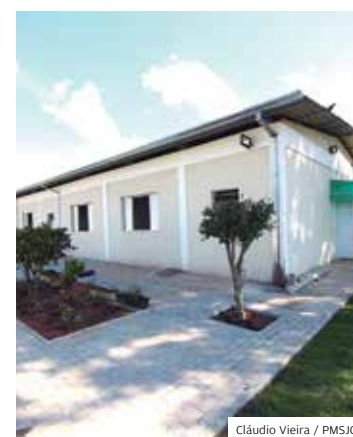
Estrutura. Abrigo para idosos
