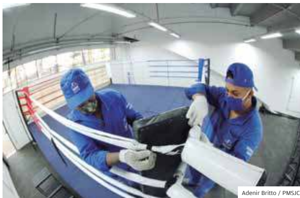
Instalações. Funcionários montam ringue de boxe
