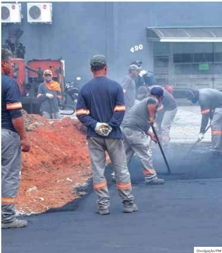
CAF. Obras feitas no pacote do CAF, na região central de Taubaté
