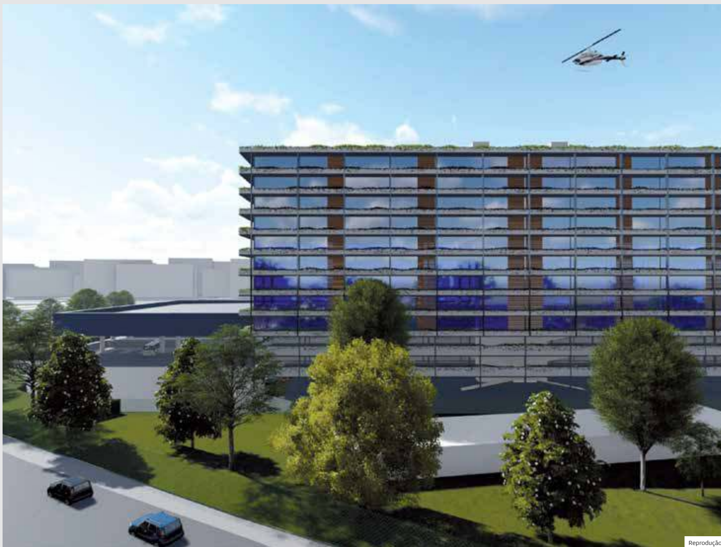
Paço. José Saud (MDB) buscará ajuda de União e Estado para construir nova sede da Prefeitura de Taubaté, estimada em R$ 36 milhões
